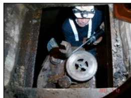
バルブ点検状況
