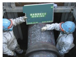
管体老朽度調査状況
