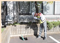
宅内漏水調査
