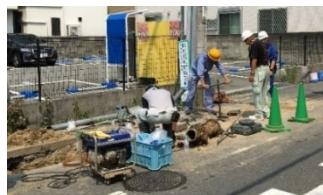
断通水作業状況
