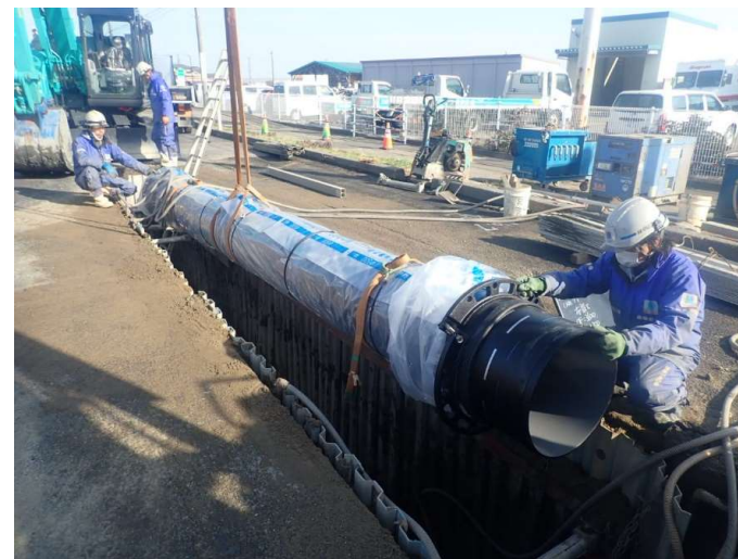
基幹管路耐震化工事の作業状況
