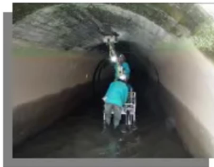
管路内から管路背面の地盤 の空洞調査の様子※
