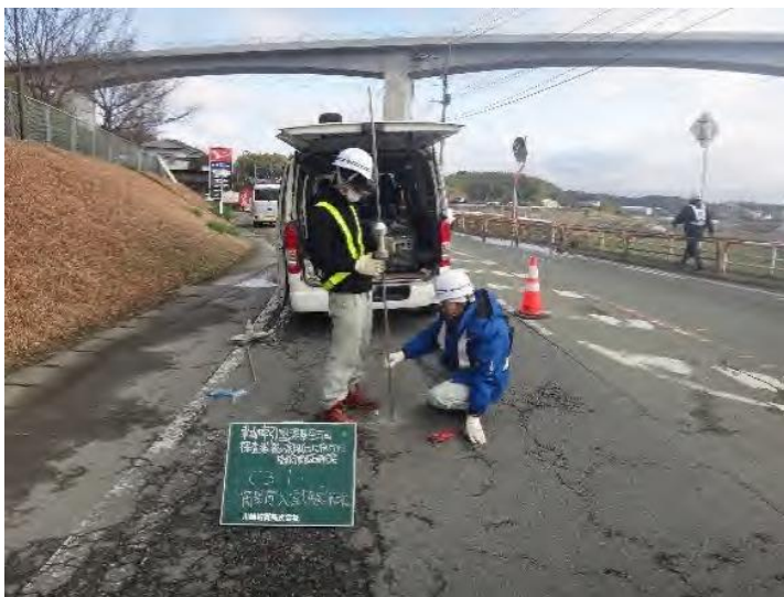
路面からのボーリングによる 空洞調査
