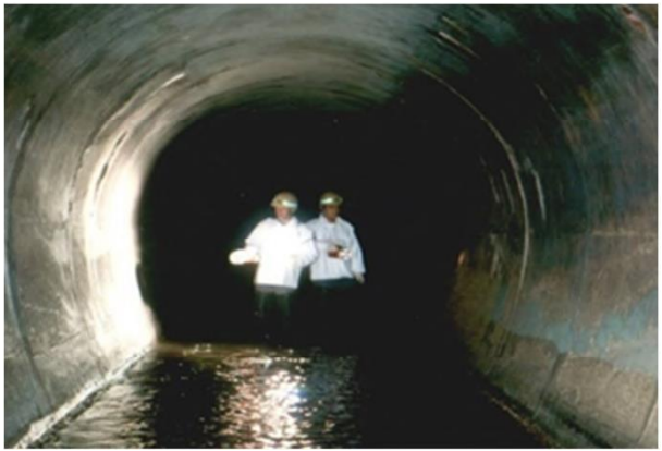
大口径管路の潜行目視調査の様子
