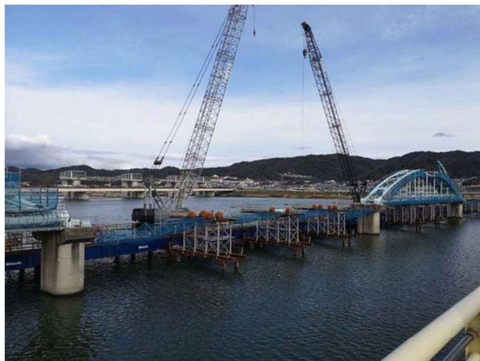
【本復旧工事の状況】
