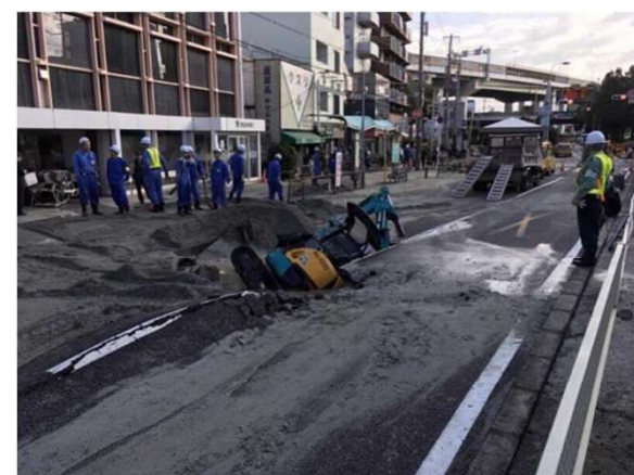
1000mm 鑄鉄管漏水による道路陥没 (H28大阪市)
