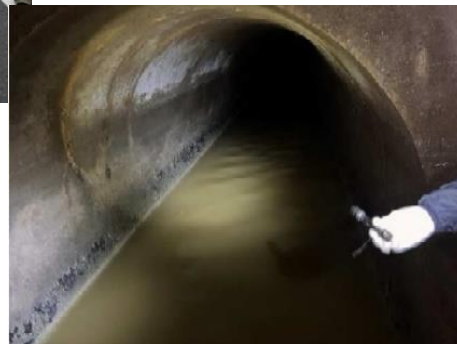
下水道管路の緊急点検の様子 (目視点検)
