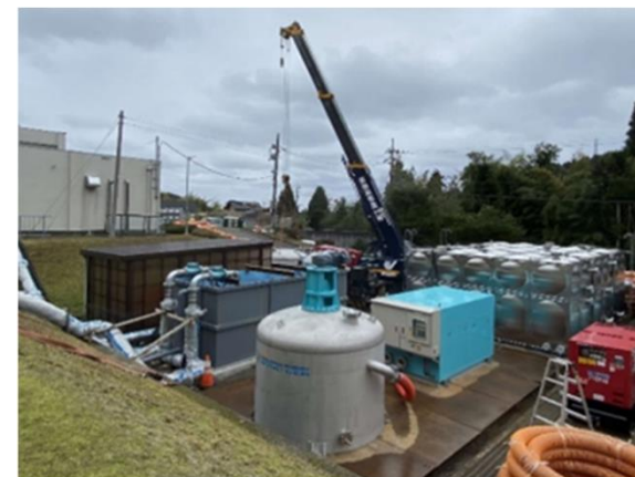
可搬式浄水施設・設備 (珠州市)
