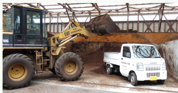
汚泥コンポストの積込みの様子
