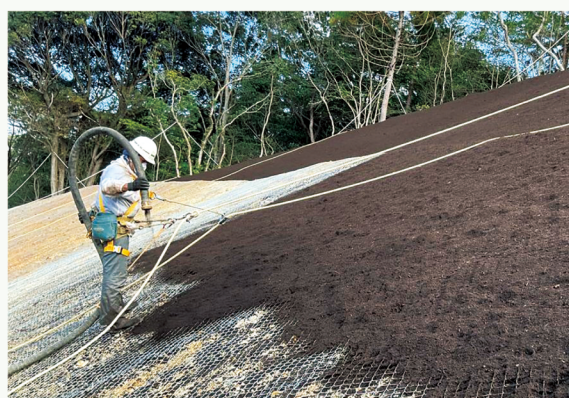
法面緑化工事での使用の様子
