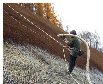
植生基材吹付工の様子
