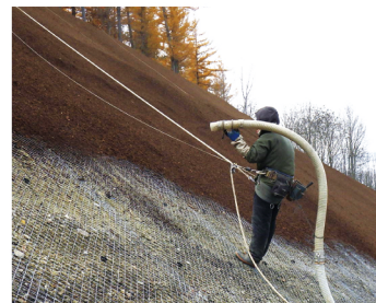
植生基材吹付工の様子
