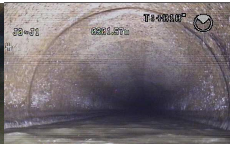
船体式テレビカメラ調査の様子と確認した異状箇所（管路内面の腐食あり）
