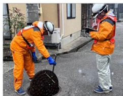
タブレットを活用した点検調査 （一部で実施）
