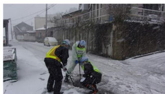
降雪の中での被災状況調査
