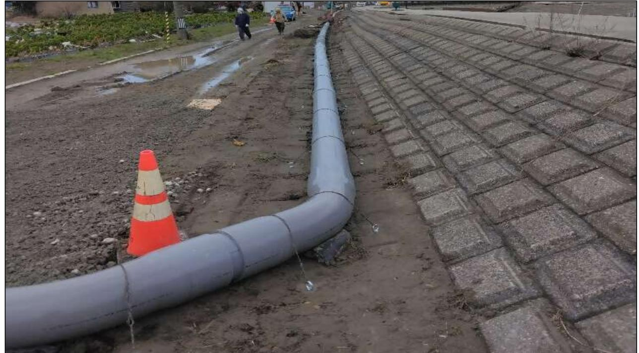
災害時における下水道の応急復旧としては **初の試み**
