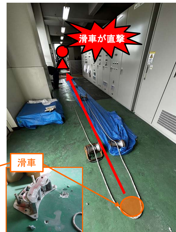
ケーブル引込用ロープによる張力で滑車が作業員に直撃
