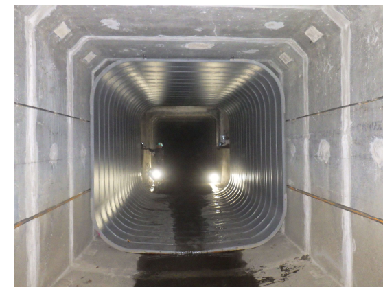
作業途中の製管状態（事故後）
