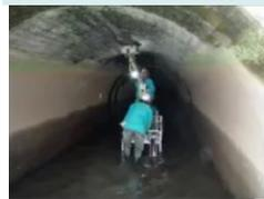
管路内から管路背面の地盤の空洞を調査
