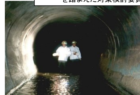
大口径管路の潜行目視調査の様子 (自走式、飛行式、水上走行式、浮流式等)
