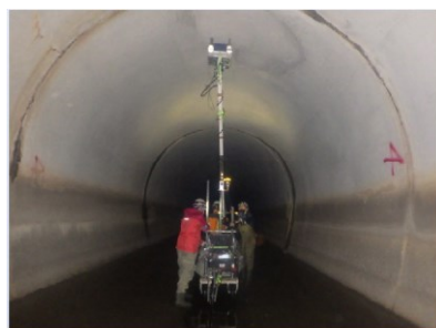
水路トンネル(大断面)
