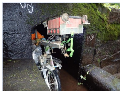
水路トンネル(狭小)
