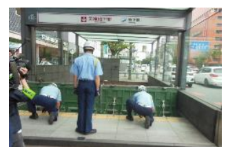
止水板設置の訓練
