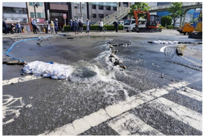
京都市国道1号で発生した漏水事故 (4/30)
