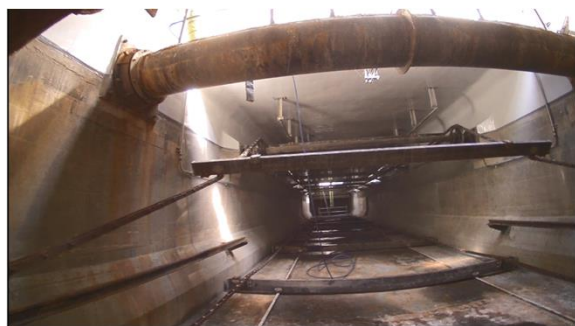
ドローンによる確認映像 (第一沈殿池内)
