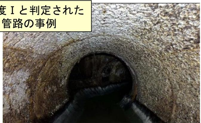
管の腐食から緊急度Ⅰと判定
