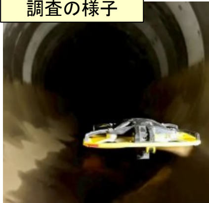
ドローンによる目視調査
