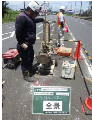
貫入試験による空洞調査
