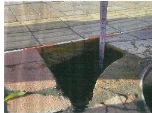
写真 取付管(陶管)での道路陥没②(福岡県古賀市)
