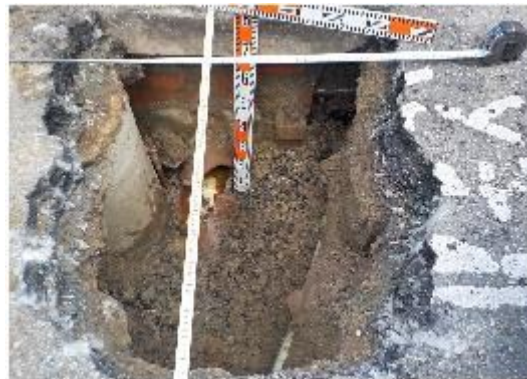
写真 取付管(陶管)での道路陥没①(大阪市)
