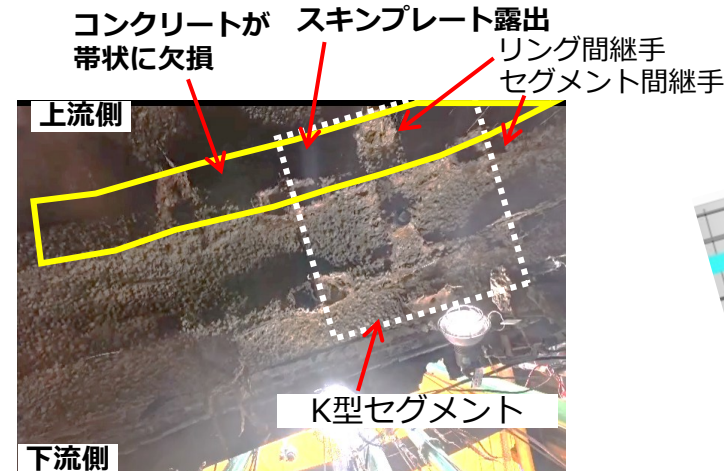
写真② シールドマシン残置部内のRCセグメント詳細（事故後撮影）
