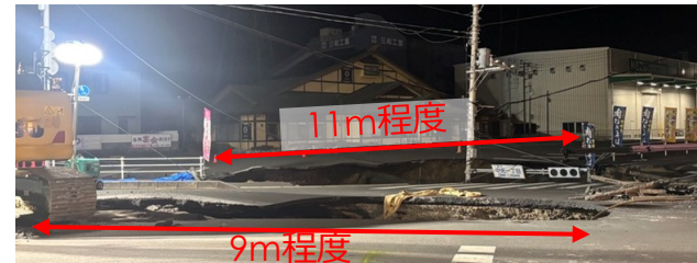
図1.2 道路陥没の拡大
