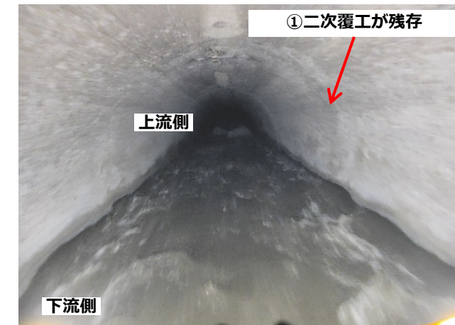
写真⑥ チュウ4MHから下流100m付近の状況 (事故後に撮影・撮影日 2025/2/5)
