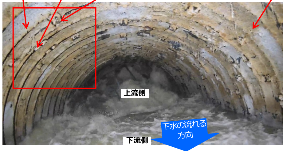
写真④ チュウ4MHから下流20～50m付近の状況 (事故後に撮影・撮影日 2025/2/5)
