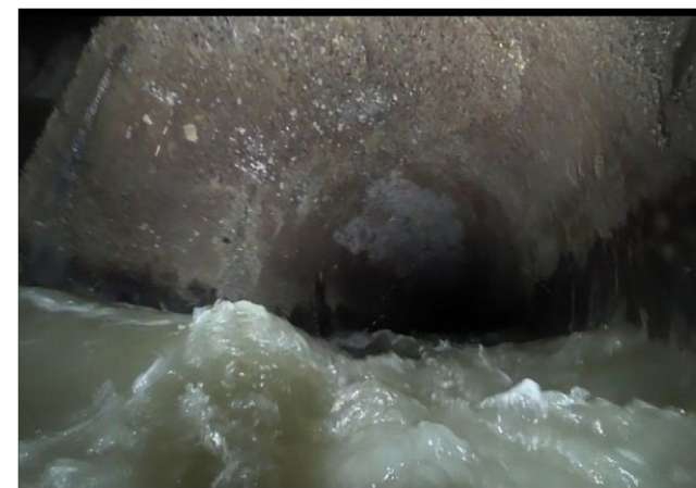
浮流式TVカメラ調査による写真 (全国特別重点調査)
