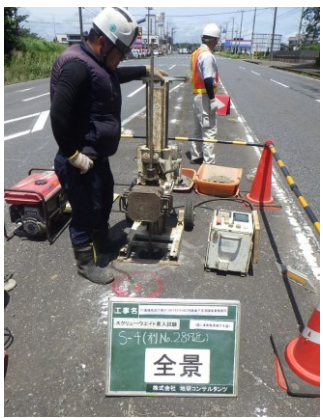
貫入試験による空洞調査
