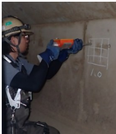
反発度法（リバウンドハンマー）による 圧縮強度調査
