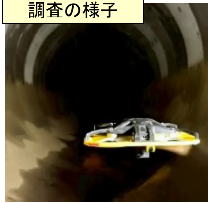
ドローンによる目視調査
