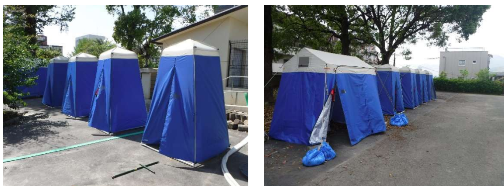
マンホールトイレ設置状況
