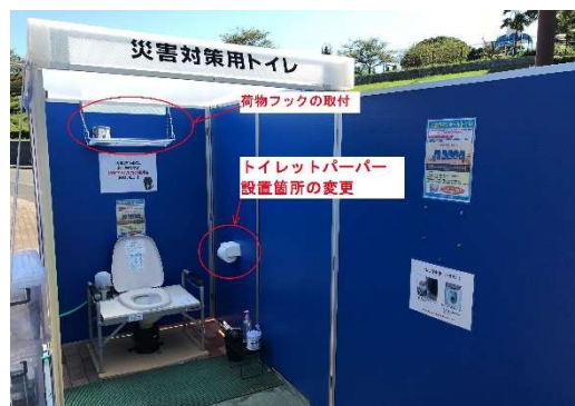
マンホールトイレの改良点
