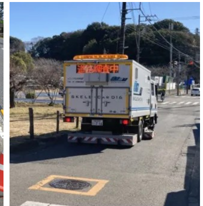
空洞探査車による空洞調査
