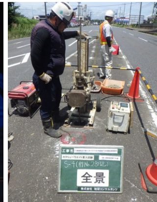
貫入試験による空洞調査
