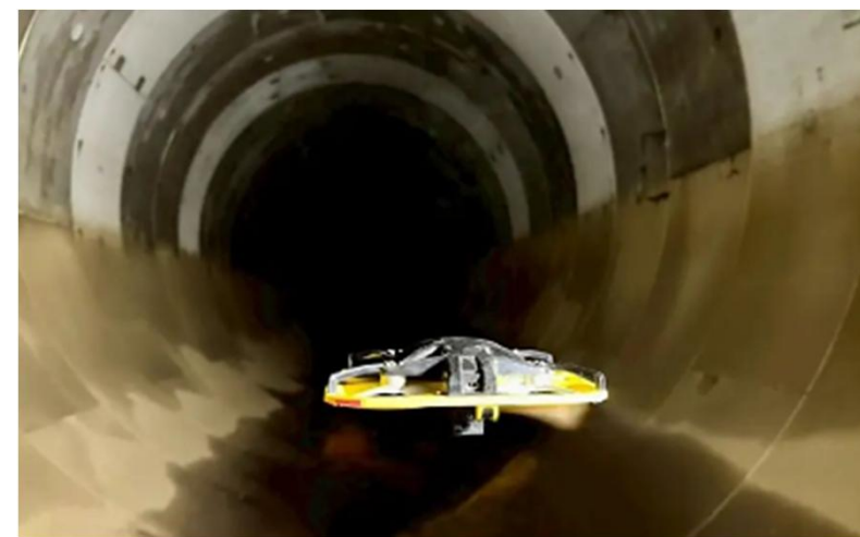
小型ドローンによる下水道管点検技術
