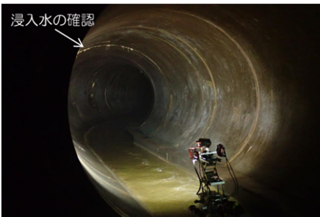
大口径下水道管の全国特別重点調査の様子
