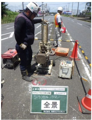
貫入試験による空洞調査
