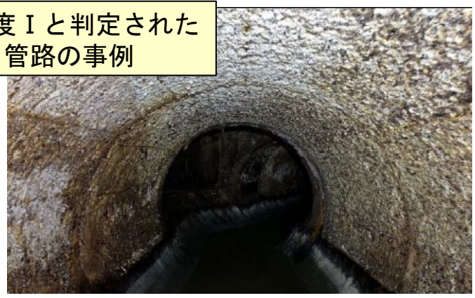
管の腐食から緊急度Ⅰと判定
