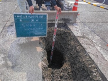
空洞が確認された箇所の状況
