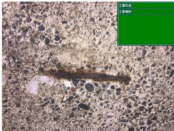
鉄筋が腐食し断面が欠損した状態の例①
