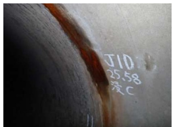
腐食した鉄筋の錆汁が発生している状態の例②
