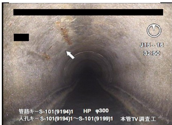
腐食した鉄筋の錆汁が発生している状態の例①
