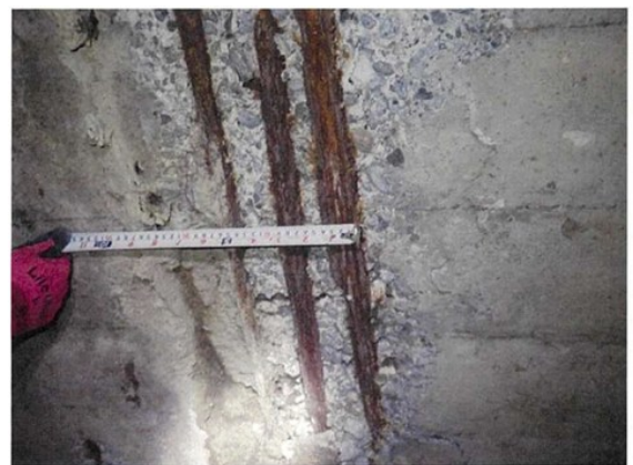
鉄筋が腐食し断面が欠損した状態の例②
