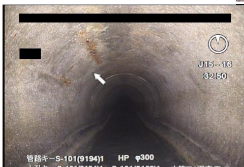
腐食した鉄筋の錆汁が発生している状態の例①
