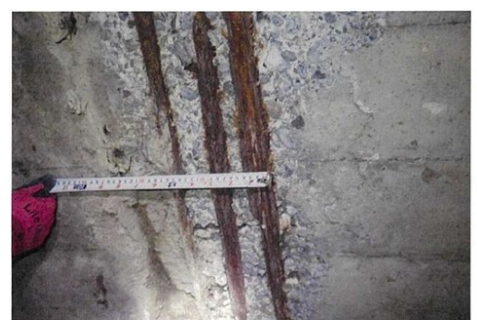
鉄筋が腐食し断面が欠損した状態の例②
