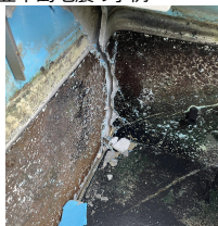
浄水場沈澱池の躯体ひび割れ
