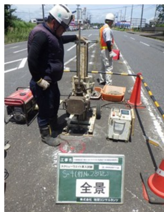
貫入試験による空洞調査
