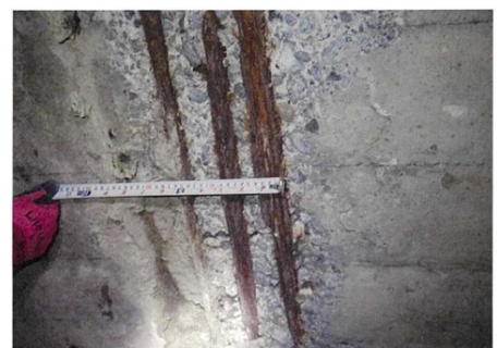
鉄筋が腐食し断面が欠損した状態の例②
