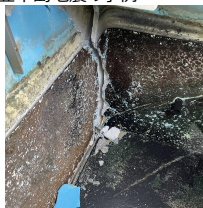
浄水場沈殿池の躯体ひび割れ
