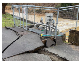
浄水場取水口の損傷
