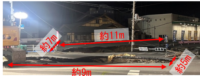
図1.2 道路陥没の拡大
