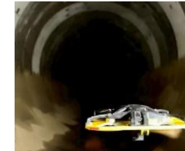
ドローンによる目視調査
