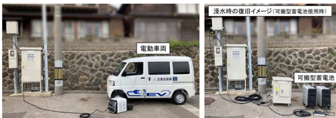
図 4-3 システム導入による停電時(左)および浸水時(右)の復旧イメージ
