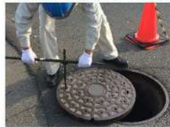
図 4-14 業務対応マニュアルの例(マンホールの開閉)
