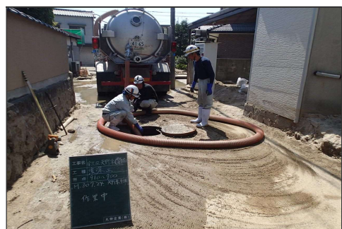
管路内土砂除去状況 (広島市)
