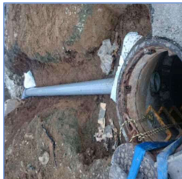
別幹線MHへ仮設管を布設
