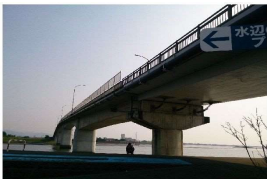
(13) 緊急点検(圧送管・橋梁添架確認)耐震L2
