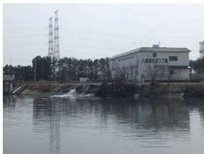
仮設ポンプによる排水
