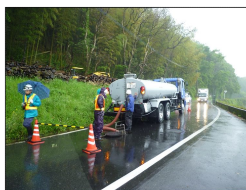
流域下水道マンホールへし尿投入
