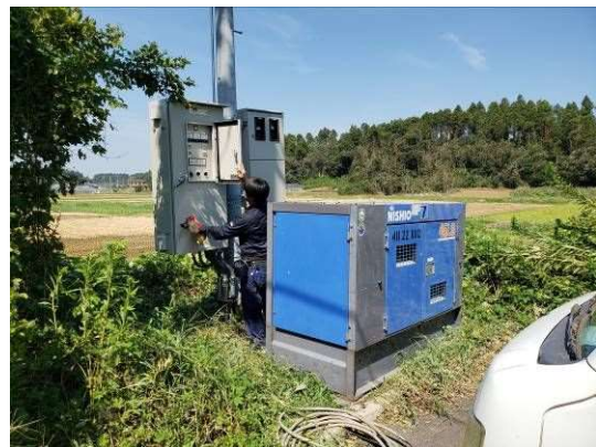
可搬式発電機設置作業（マンホールポンプ）
