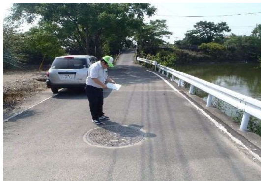
(13) 緊急点検状況(管渠・MH)
