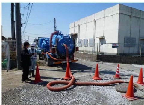
汚泥吸引車による吸引状況
