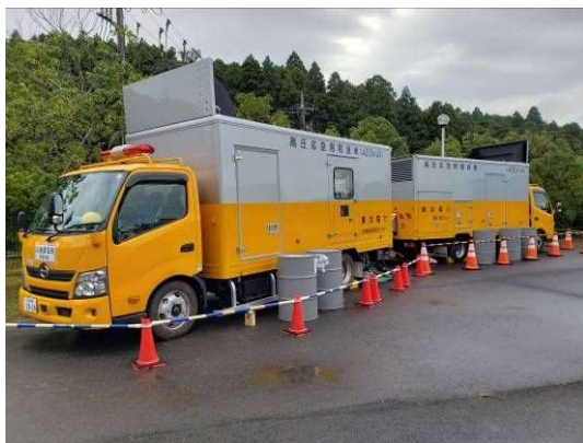
電源車設置状況（芝山CC）
