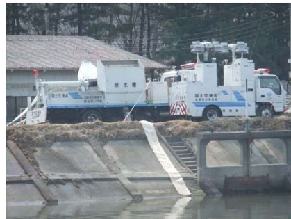
移動ポンプ車による排水
