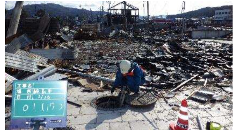
輪島市 雨水1次調査
