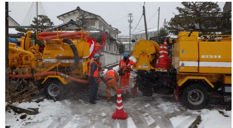
内灘町 汚水2次調査
