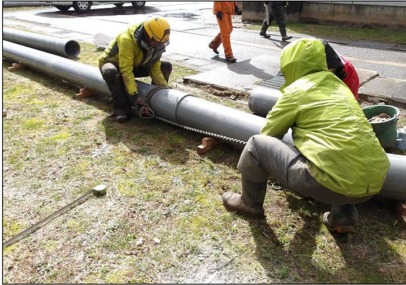
珠洲市浄化センターへ 約1.6kmの仮設圧送管を布設
