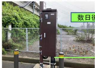
制御盤を上げる前
