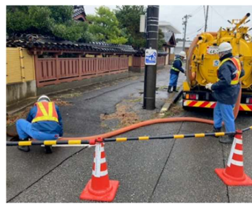
図 3-4 最終沈殿池からの採水および下水道管路の流下機能の確認の様子
