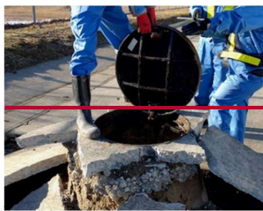
図 3-3-3 最終沈殿池からの採水および下水道管路の流下機能の確認の様子
