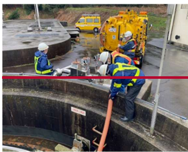
図 3-3-3 最終沈殿池からの採水および下水道管路の流下機能の確認の様子
