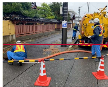
図 3-3-3 最終沈殿池からの採水および下水道管路の流下機能の確認の様子
