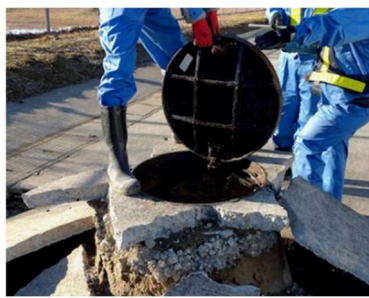
図 3-4 最終沈殿池からの採水および下水道管路の流下機能の確認の様子
