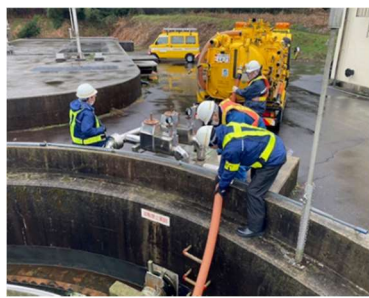
図 3-4 最終沈殿池からの採水および下水道管路の流下機能の確認の様子
