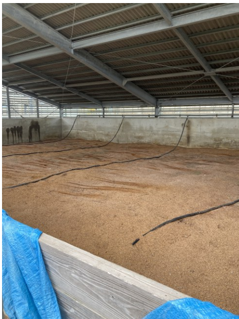
図 II-3 生物脱臭装置
