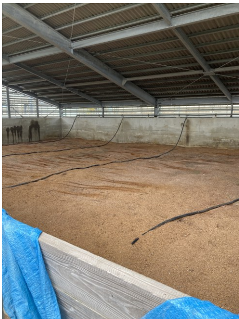
図 II-3 生物脱臭装置
