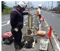
（貫入試験による調査）
