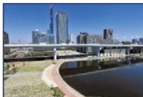
運河堀止部 (水質改善に利用)
