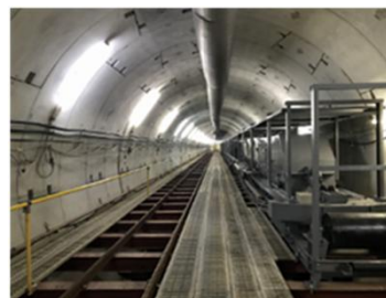
雨水貯留管の整備
