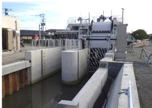
雨水ポンプ場の整備
