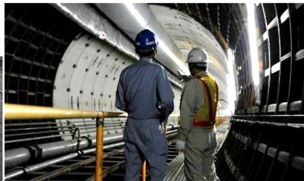
雨水貯留管の整備
