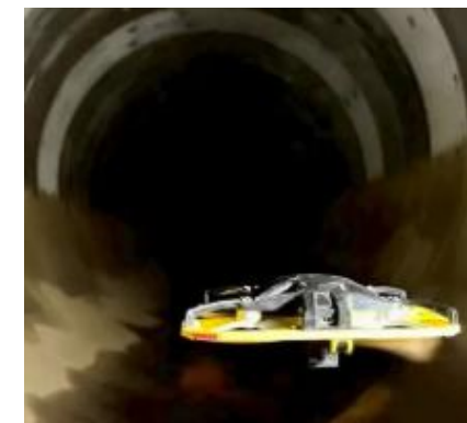
ドローンによる目視調査
