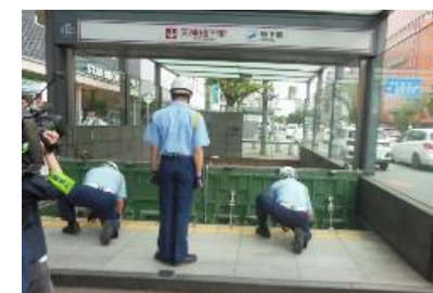
止水板設置の訓練
