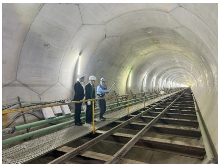
下水道管路の複線化事業（東京都千代田幹線）
