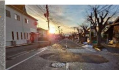
< 仮復旧完了済み >
