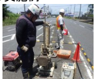
(貫入試験による調査)
