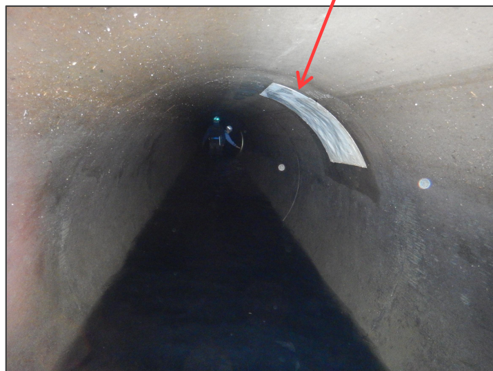
部分修繕の例
