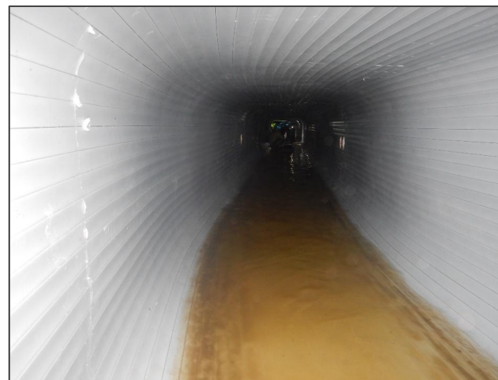
管更生工法による改築の例
