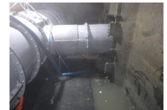
複線化・連絡管接続
