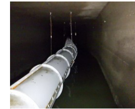
管きよ内バイパス化
