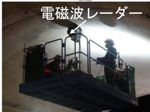
トンネル背面の空洞調査事例※
